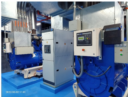
ห้องเครื่องกำเนิดไฟฟ้าสำรองมีการבודด้วยวัสดุดูดซับ
