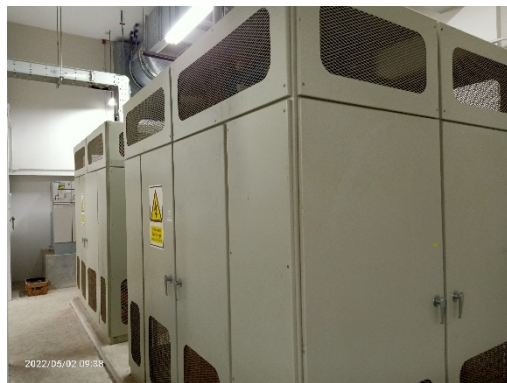
หม้อแปลงไฟฟ้า อาคารพักพยาบาล
